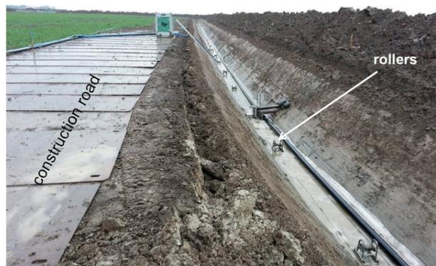
Abb. 2: Baustelle im offenen Verfahren. Baustraßen und Verlegung (ABB 2015)
