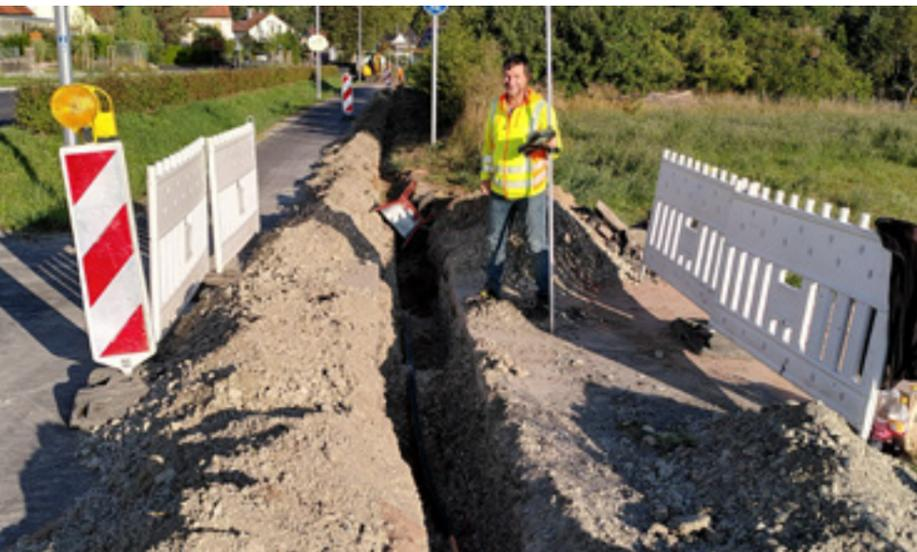
Erd- und Verlegearbeiten von Rohrleitungen unter anderem für den Breitbandausbau bei Aura an der Saale.
