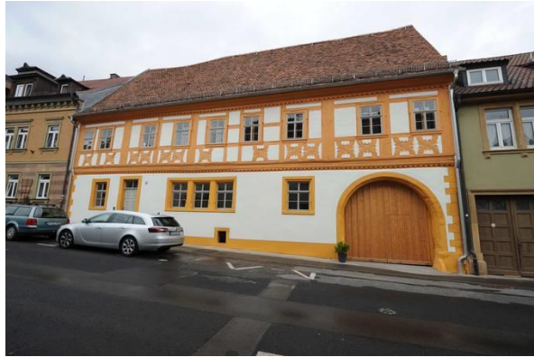
Sanierung eines denkmalgeschützten Wohnhauses in Gerolzhofen, Landkreis Schweinfurt
