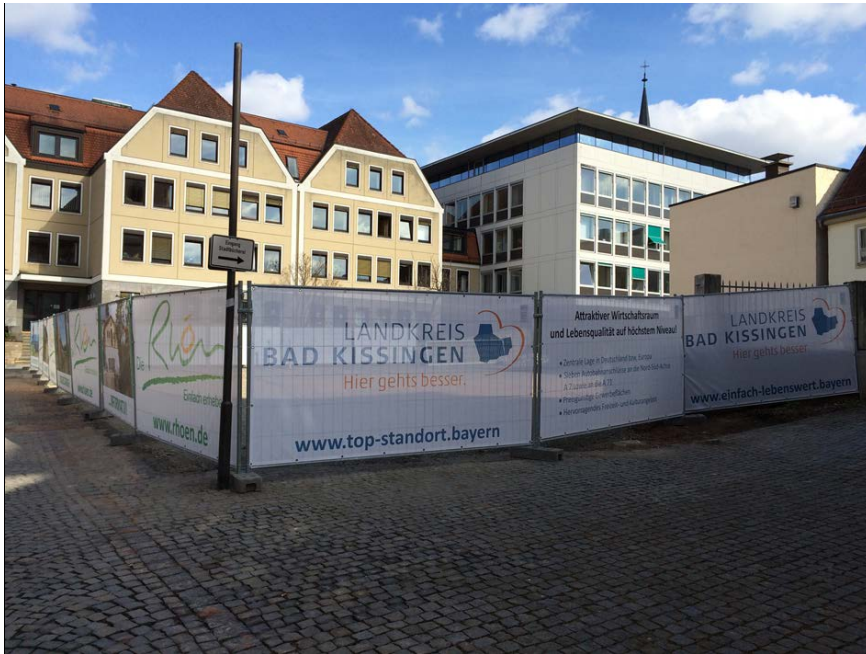
Baustelle für den Erweiterungsbau des Landratsamtes Bad Kissingen
